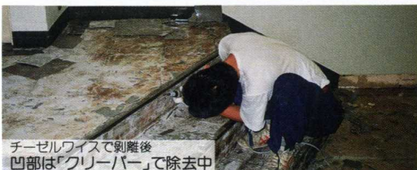
階段の垂直面も、途中から喰い込ませバリバリ剥離するチーゼルワイス
