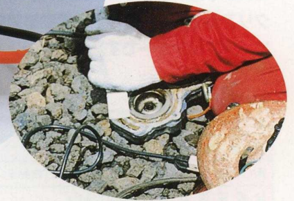
パッキン塗膜はがし
