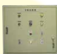
自発停型発電機※1 電源切替盤(ATS盤)※2
